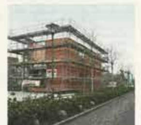
Fest fertig. Es fehlt nur noch das Dach und das Markenzeichen, die Kaffeetasse.
