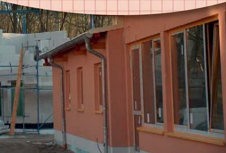
Baub Abschnitt im Dezember 2004
